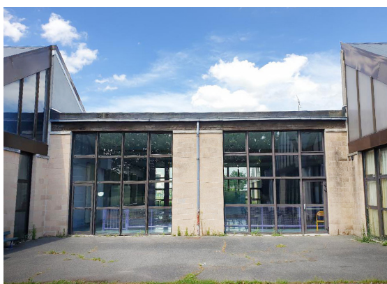
Une ancienne école maternelle réhabilitée pour accueillir les élèves à Sevrans
